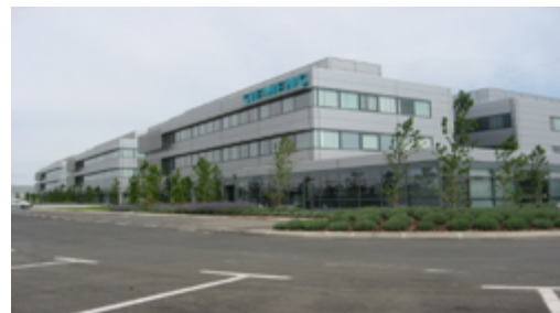
Centro I+D+I SIEMENS (Getafe)
